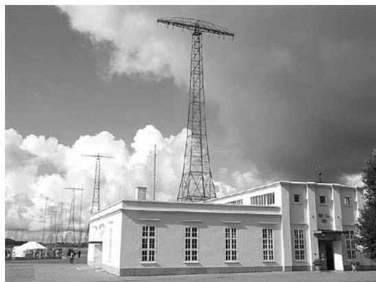
SAQ Grimetons stationshus med antenntornen i bakgrunden.
