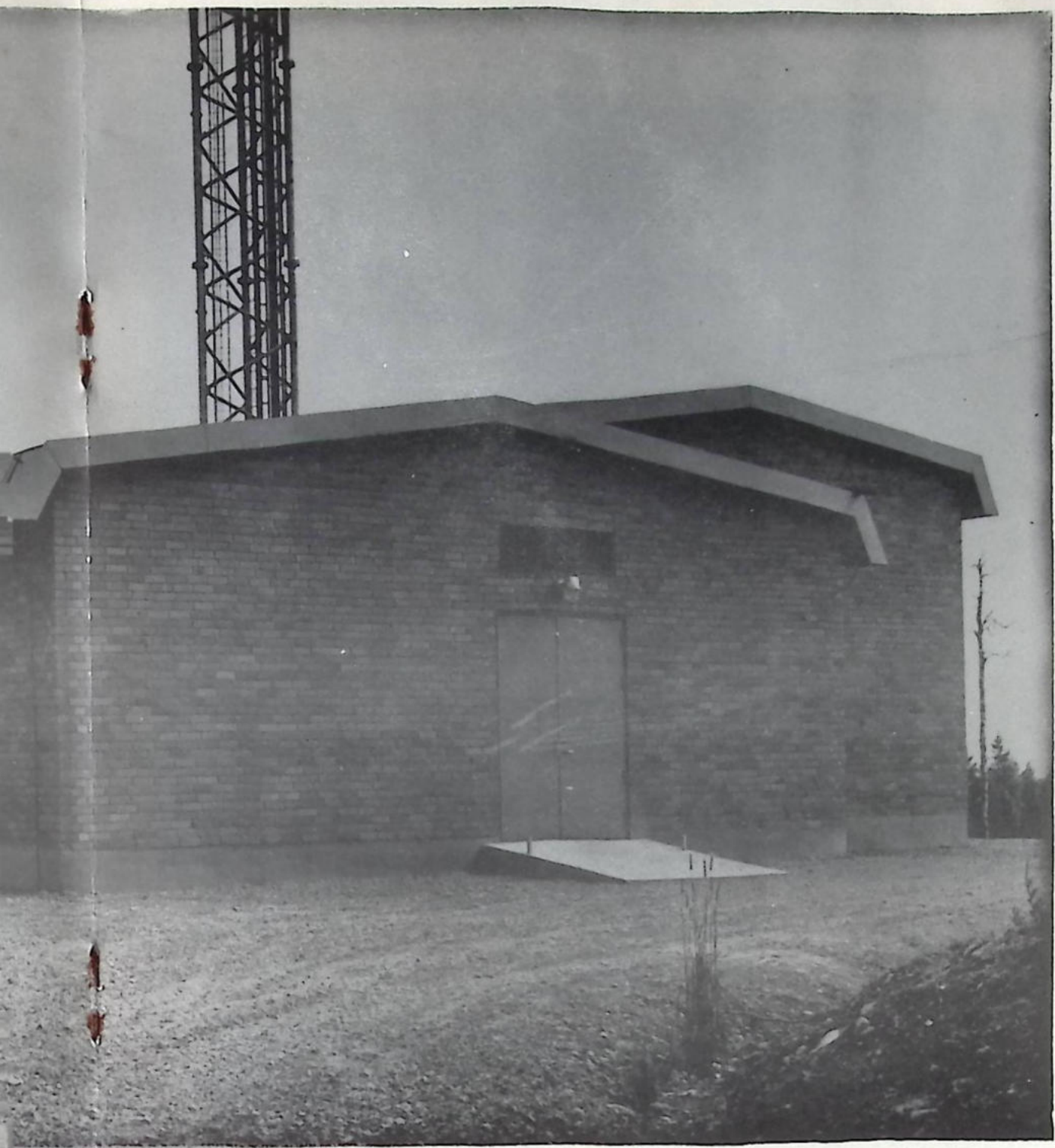
Stationsbyggnaden är uppförd invid masten och har en golvyta av 500 m 2 i ett plan. Större delen av utrymmet upptages av sändarsal, kontrollutrymme, rum för radiolänkutrustning samt personalutrymmen. I kontrollrummet finns övervaknings- och mätutrustning för de olika sändarna.
