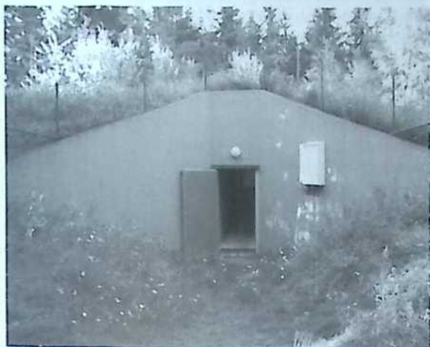
Ingången till bunkern.
