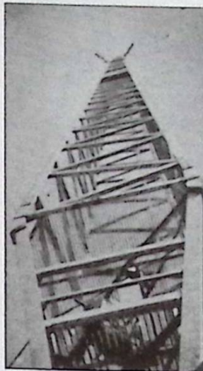
Bild av den 130 m höga masten tagen vid foten alldeles intill den steatitkulan på vilken den vilar. Överst skymtar tre av de fyra fadingspröten samt isolatorerna till ett par av de fyra stagen.
