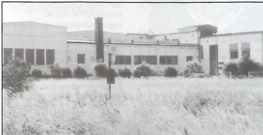
I stationens huvudbyggnad från 1927 finns LV- och reservsändarna. I annexet till höger, som byggdes 1932, finns MV-sändaren.
