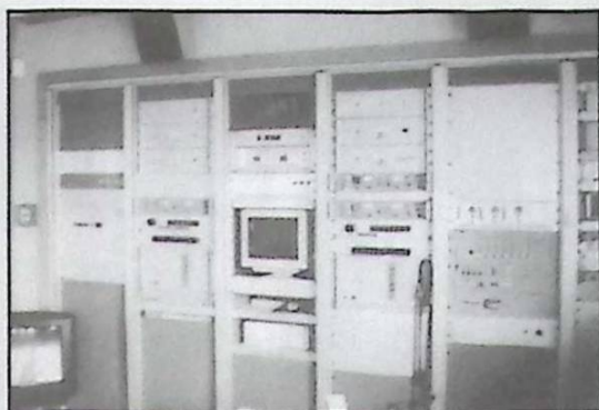
I kontrollrummet finns bland annat bärvågsoscillatorn och mottagarutrustning för modulationen (programmet) från studion i Köpenhamn.
