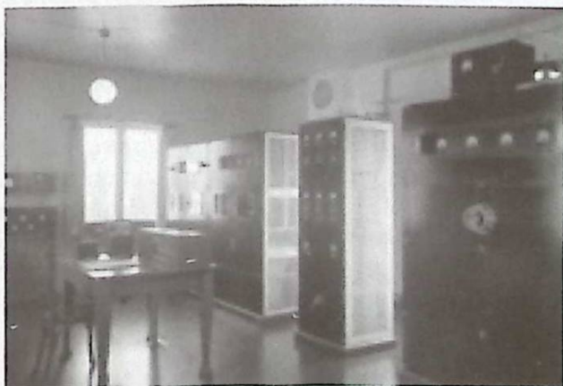
Interiör från sändarrummet i den gamla stationen.
