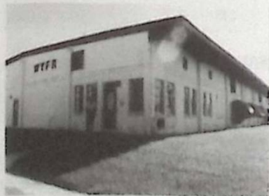
NDL:s Göran Bayard utanför stationsbyggnaden hos WYFR, Okechobee, FL. (Foto: CON)
