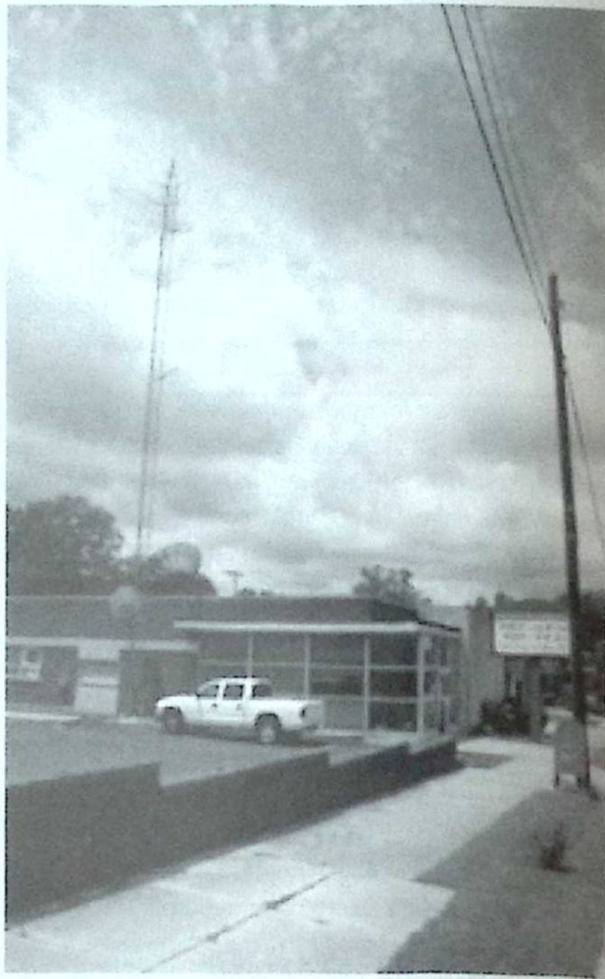
Stationshuset med mast.
