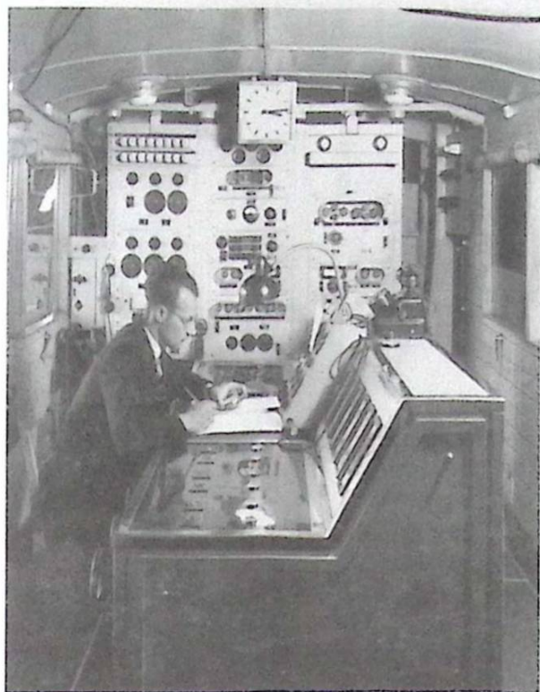
Manöverpulpit och övervakningspanel för slutsteget.
